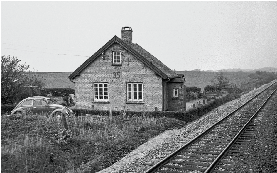
Figur 1.9: Banevogterhus nr. 35 i Sværdborg få kilometer syd for Ring. Huset, der er forsynet med en lille knast – et såkaldt skilderhus – i facaden ud mod jernbanen, er af den type, der blev bygget mange af i forbindelse med anlægget af Sydbanen i 1868-70. Huset havde en kvadratisk grundplan og vinduer i gavlen. Det bestod af forstue, køkken og to værelser, og det indvendige beboelsesareal var kun ca. 34 m 2 . Banevogterhuset i Ring, der i hvert fald i 1890 havde nummeret 33, har været næsten identisk med det i Sværdborg (Foto: J. Bruun-Petersen).
