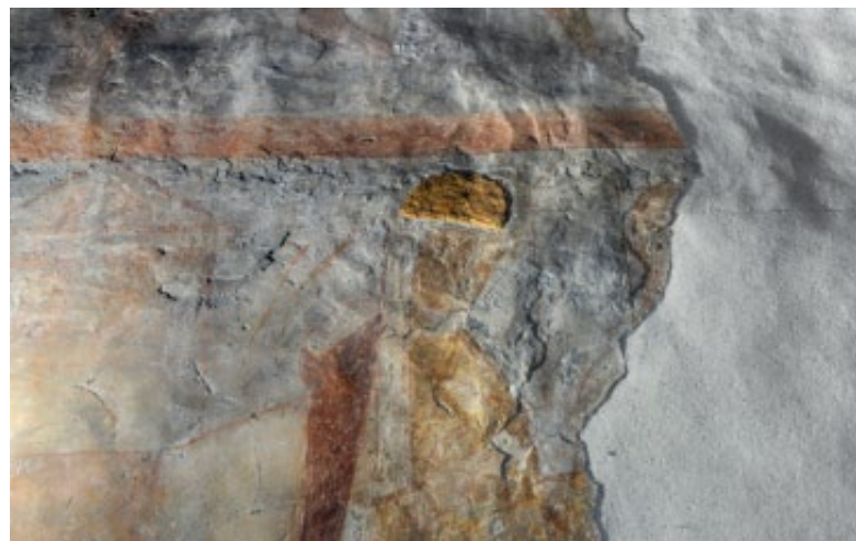
0.4 Måløv Kirke. Eksempel på vertikal stødfuge. Foto Herman Andersson
