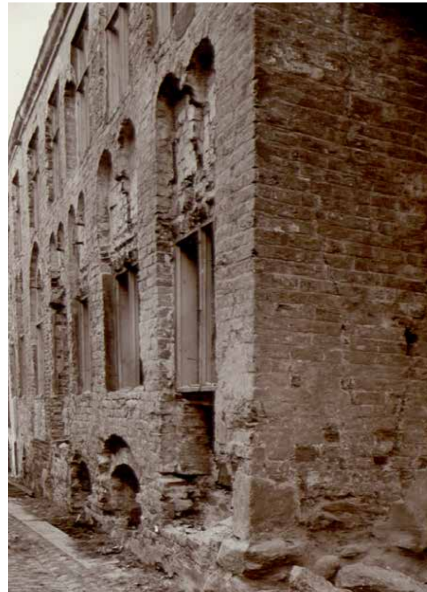
Figur 2.6. Sydøsthjørnet på det såkaldte Budolfi Kloster kort før nedbrydningen. Trods husets medtagne forfatning ses det, at munkestensmurværket har givet facaden en meget fin stoflig virkning. Foto: C.M. Smidt 1906, Nationalmuseet.
