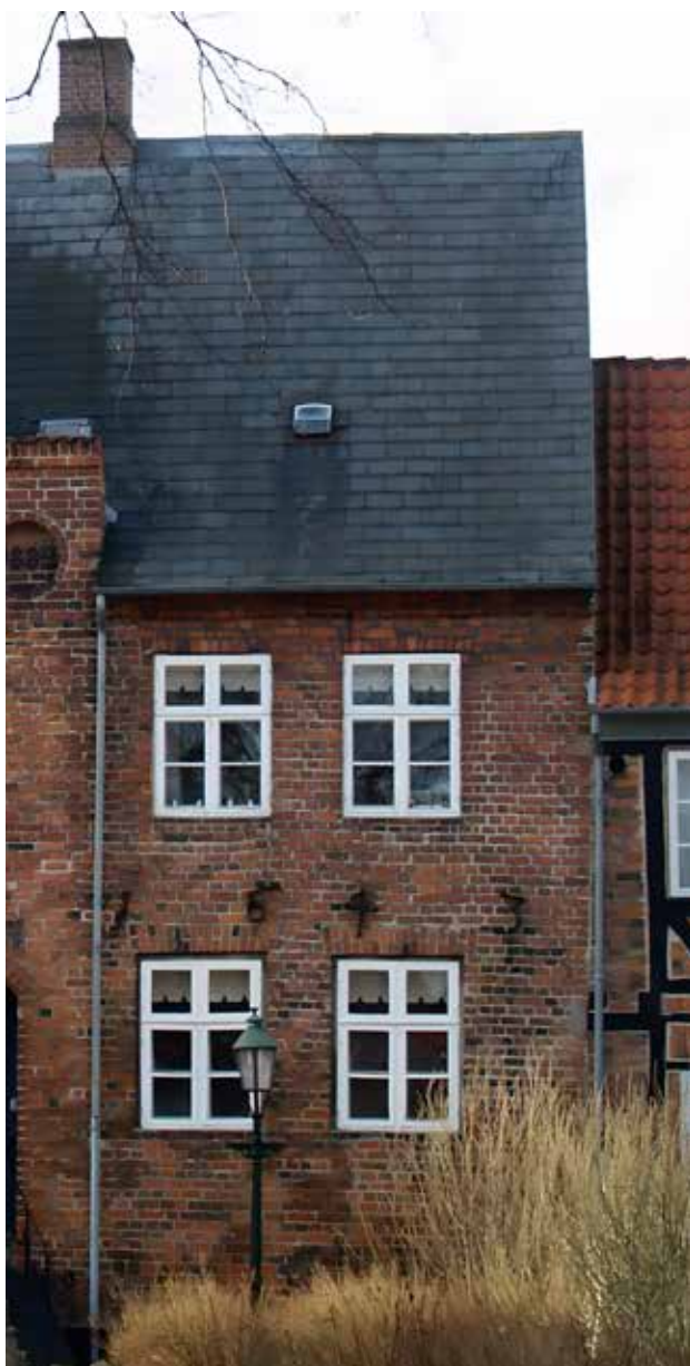
Figur 2.7. Sidehuset ved Sct. Mogens Gade nr. 9. Murstenene er lidt mindre end i gavlhuset og stenene er oplagt i krydsskifte. Murankrene former årstallet 1643, hvilket forekommer sandsynligt for opførelsen. Murværket indeholder en del reparationer, og man må formode, at der er indsat nyere vinduer. Foto: HKK 2011.
